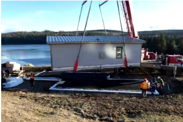
In British Columbia im Westen Kanadas ist ein erstes innovatives Wohnhaus mit einer Bodenplatte aus Holz entstanden. Das Haus überzeugt durch seine nachhaltige Bauweise, die bereits bei der Gründung mit einer Bodenplatte aus Holz beginnt, und im Passivhausstandard in der Nutzung überzeugt.
