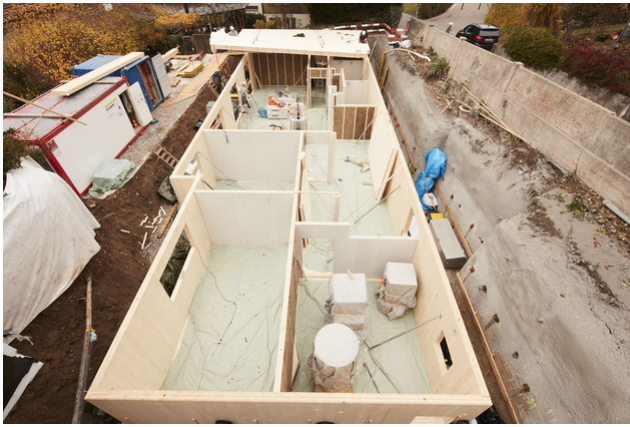
Untergeschoss während der Bauphase
