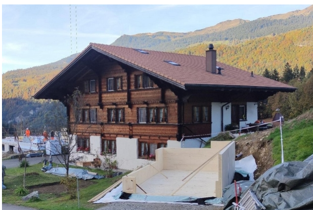
Brettsper Holzplatten sind vergossen
