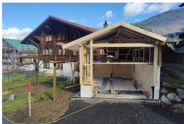
Auf den CLT-Platten wird der Holzbau aufgerichtet
