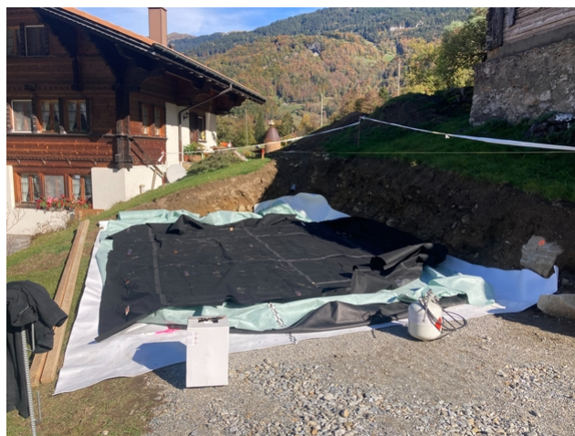
Abdichtung und Feuchtemonitoring ist bereit
