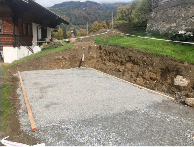
Das Kiesbett als Grundlage für die Garage
