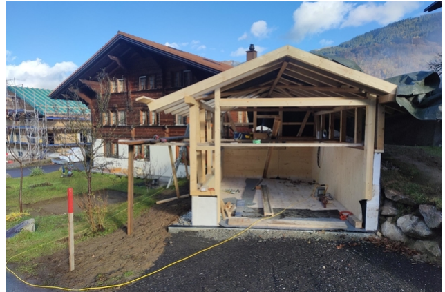
Auf den CLT-Platten wird der Holzbau aufgerichtet
