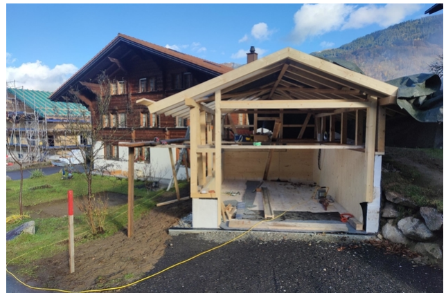
Auf den CLT-Platten wird der Holzbau aufgerichtet
